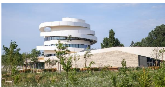
La Cité à Beaune par Emmanuelle Andreani Architecte ©Antoine Martel
